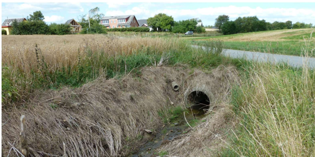
Billede af udløb, rørlægning AAL-1180_c.
