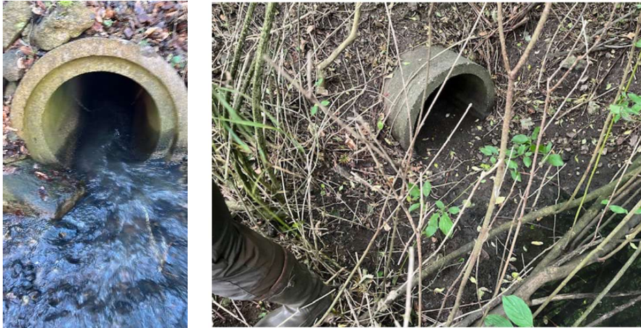
Henholdsvis ind- og udløb (station 457 og station 508), rørlægning AAL-1180_b.
